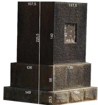
Abb. 1 Abmessung des Sockels in cm
